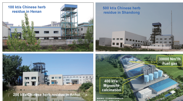
图 12 耦合燃料预氧化的流化床两段气化对典型高含水高挥发分燃料的工业应用
